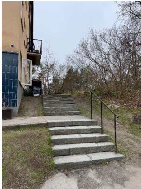
Trappa av granitblock.
