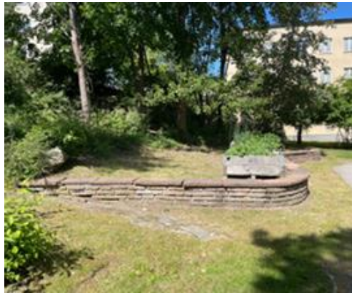
Stödmur av kalksten.
