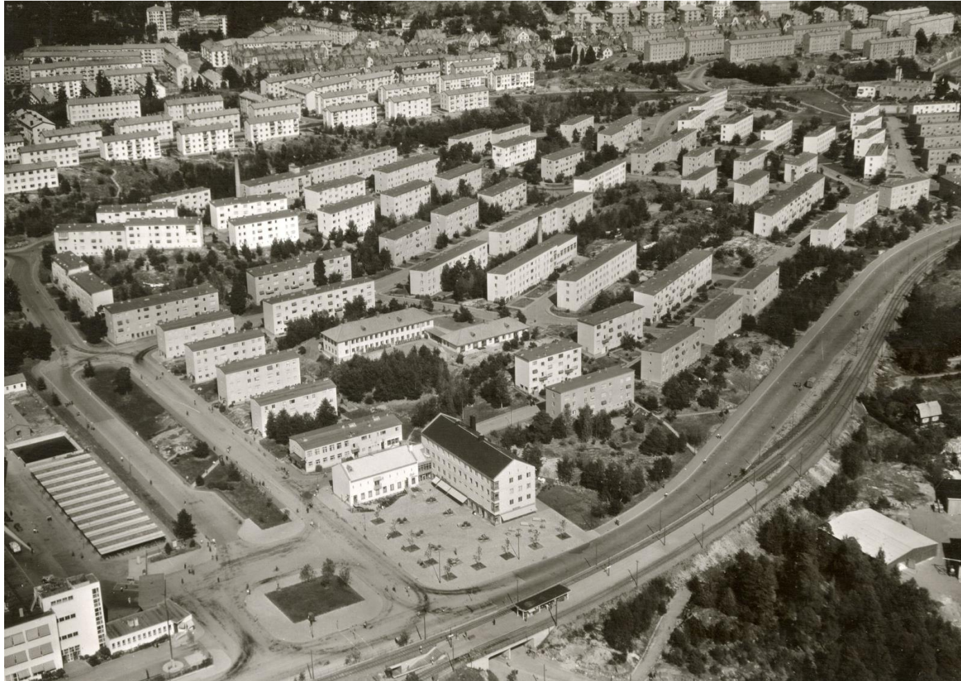
Bostadsrättsföreningarna Tele och Tellusborgshus strax efter uppförandet. L M Ericssons fabrik till vänster. Foto Centrum för Näringslivshistoria.
