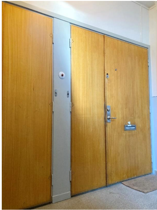
Ursprungliga lägenhetsdörrar av alm med pardörr för att kunna ta in större möbler.
