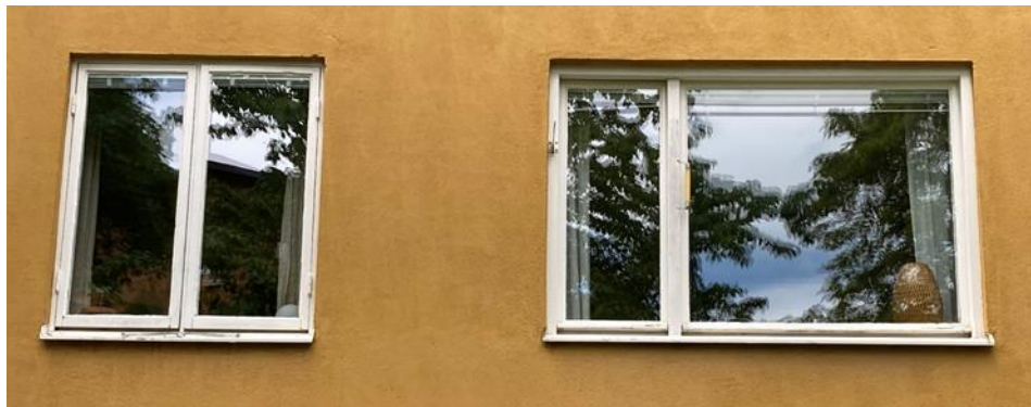
Ursprungliga fönster till sovrum med utåtgående bågar, respektive vardagsrum med inåtgående bågar.
