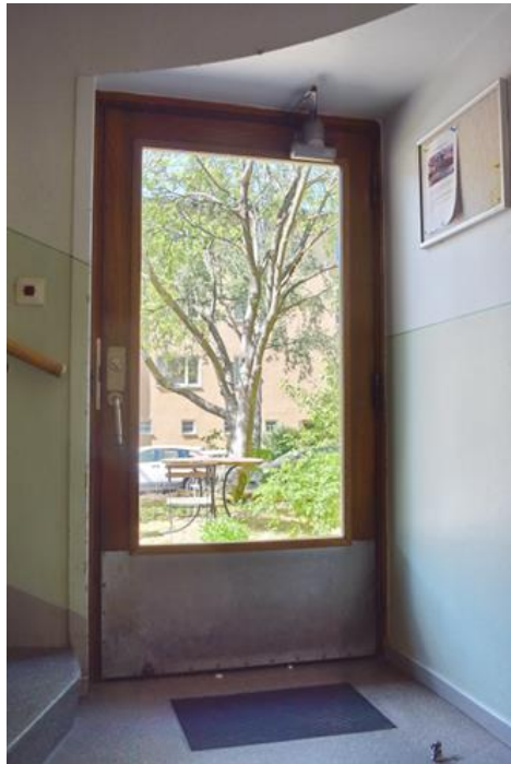
Entrédörr från insidan.
