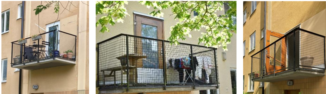
Balkonger med räcken samt balkongdörrar dörrar med olika ytbehandlingar.
